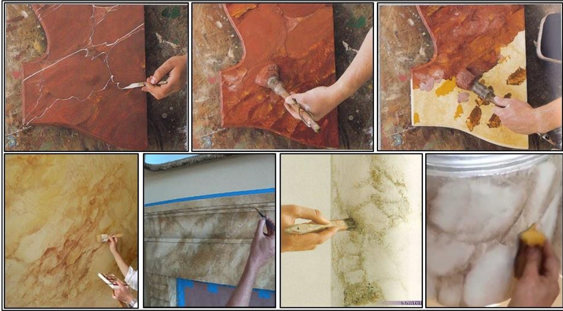
شكل رقم (3-25) يظهر طريقة الرسم في إظهار الرخام
