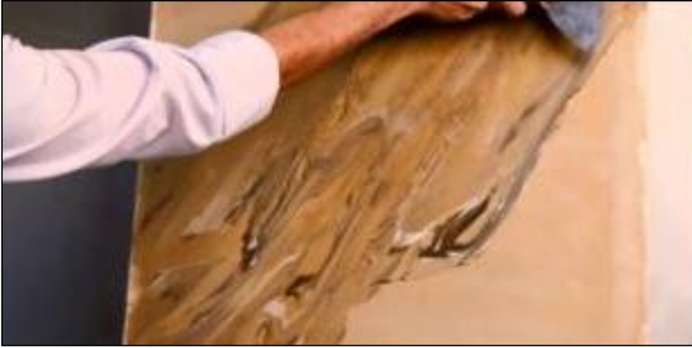
شكل رقم (3-26) إظهار الرخام بطريقة المسح
