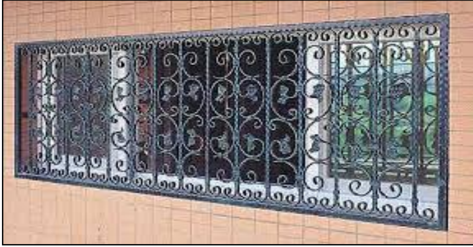
شكل رقم (3-48) إستخدام الحديد في غطاء الشبائيك
