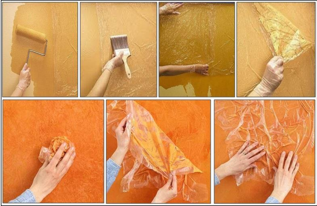
شكل رقم (29-3) طريقة التعتيق في إظهار الرخام
