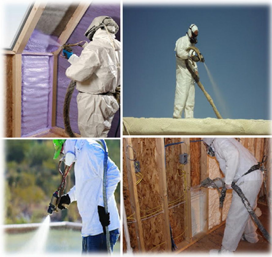
(صورة2) طريقة عمل البولي يوريثين
