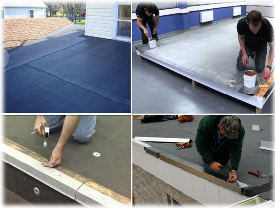
(صورة 3) طريقة العمل بلفائف المطاط
