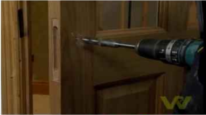
شكل (1 - 32) يبين كيفية ثقب موضع عمود
