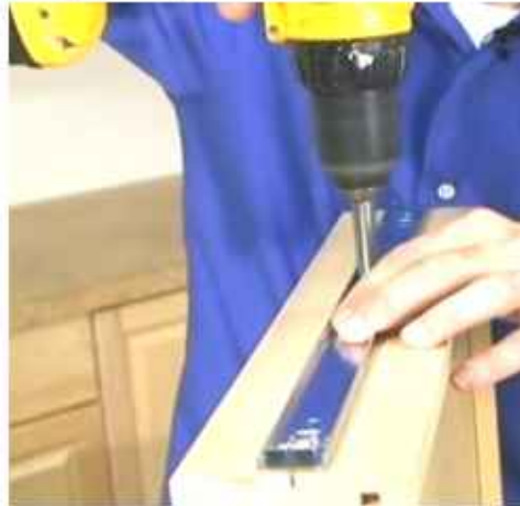
الشكل (3 - 43) يوضح كيفية تركيب جزء السكة المعدنية على جوانب الجرار
