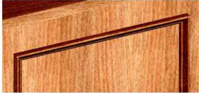
شكل (3 - 16) يبين وضع (الأبزار) أشرطة الحلية
