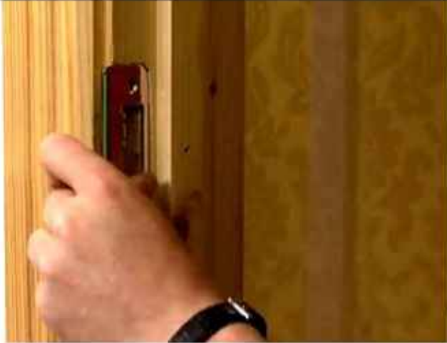
شكل (1 - 35) يبين كيفية تثبيت جزء اللسان المعدني
