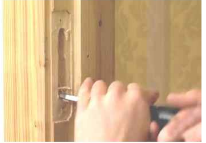
شكل (1 - 34) يبين كيفية تفرغ جزء اللسان المعدني
