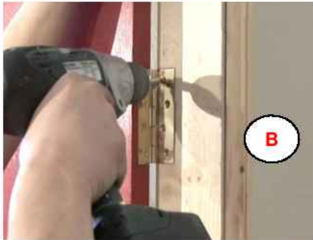
شكل (1 - 26) يبين كيفية تثبيت المفصلات بالإطار
