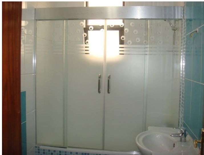
شكل (3 - 6) الزجاج المرمل واستخداماته
