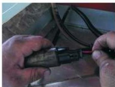
شكل (61-2) توصيل أقطاب الكهربائية للمضخة
