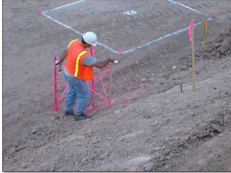
الشكل (11-1) مسح قطعة ارض وتعيين نقاط الثوابت الارضية.
