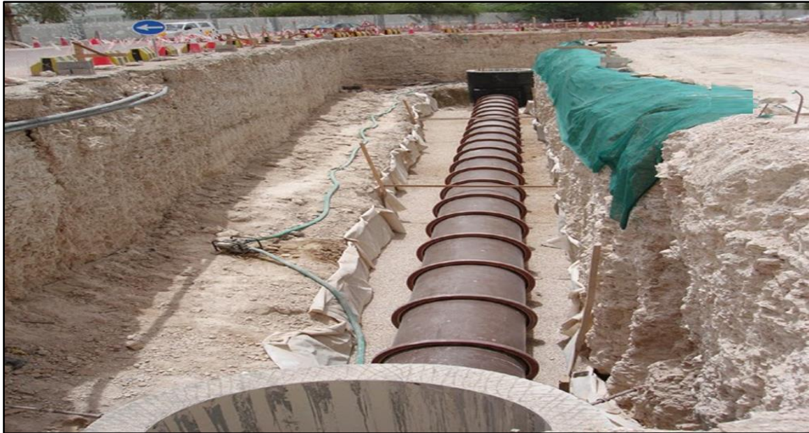
الشكل (3 – 1) مد شبكات الصرف الصحي
