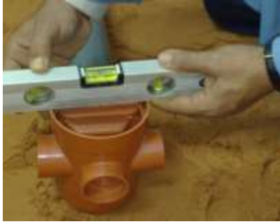
الشكل ( 5-5 ) مرحلة التوصيل بالموزع الاسطواني
