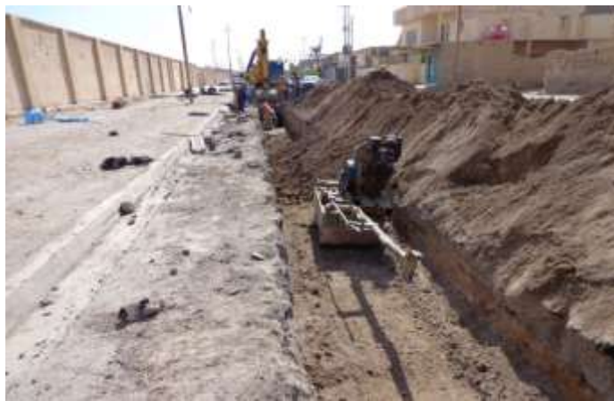
الشكل ( 4-7 ) دك خندق الحفر بعد مد الأنابيب
