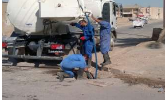
الشكل ( 2-7 ) صيانة بالوعة أمطار باستخدام الضغط العالي للماء
