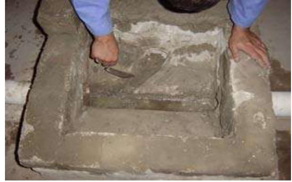
الشكل ( 5 - 32 ) أعمال بناء جدران الحوض
