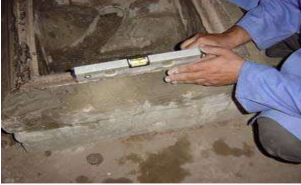
الشكل ( 5 - 33 ) أعمال تثبيت إطار الغطاء
