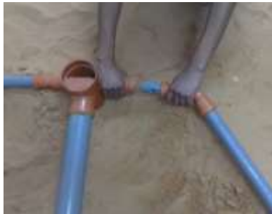
الشكل ( 6-5 ) تمديد خطوط الصرف للموزع الاسطواني
