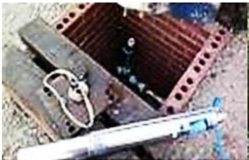
الشكل ( 3-50 ) يوضح وضع الصمّام تحت سطح الارض
