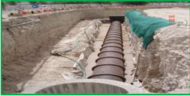
الشكل (3-6) إستقامة الخطوط بعد انشائها
