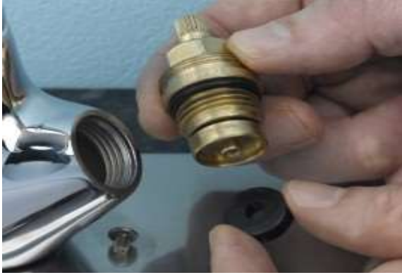
الشكل ( 39-3 ) طريقة تركيب مانعة التسرب لقلب حنفية
