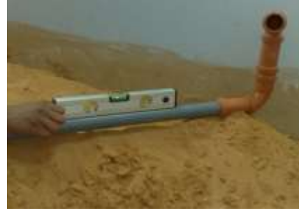
الشكل ( 6-5 ) تمديد خطوط الصرف للموزع الاسطواني
