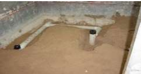
الشكل ( 5 - 11 ) ربط الموزع والسيفون بالمشترك الخارجي
