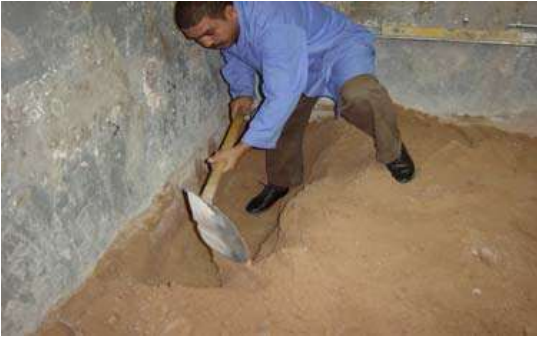
الشكل ( 5 - 9 ) أعمال الحفر
