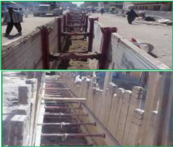
الشكل (2-6) استخدام الخنادق بسواتر خشبية
