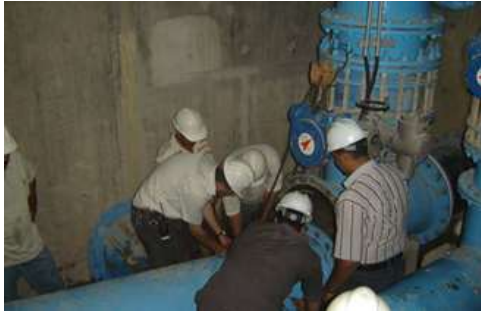
الشكل (2 - 55) يوضح عملية ابدال حشوة (كازكيت) متضررة
