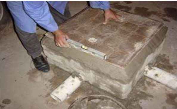
الشكل ( 5 - 35 ) أعمال تثبيت إطار الغطاء
