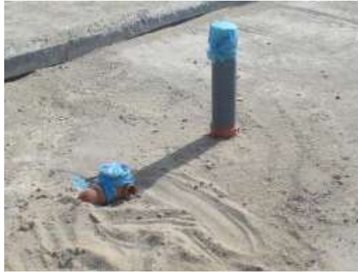
الشكل ( 5 - 17 ) شبكة الصرف بعد صب الخرسانة
