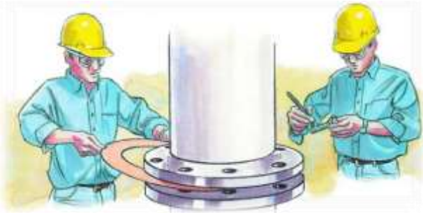
الشكل (2 - 55) يوضح عملية ابدال حشوة (كازكيت) متضررة
