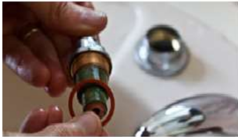
الشكل (3-26) طريقة تركيب مانعة التسرب العليا للحنفية
