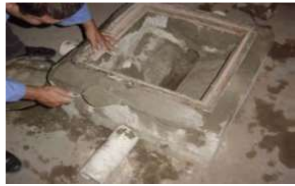
الشكل ( 5 - 34 ) أعمال تثبيت إطار الغطاء
