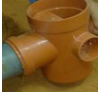
الشكل ( 5-5 ) مرحلة التوصيل بالموزع الاسطواني
