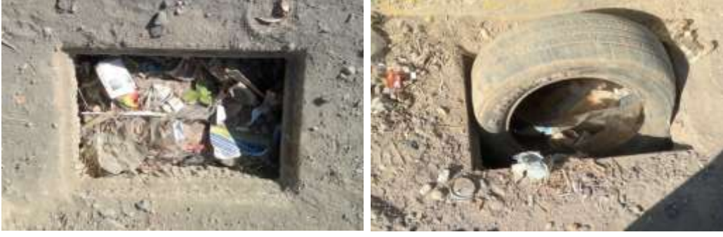
الشكل ( 1-7 ) بالوعة أمطار فيها إنسداد
