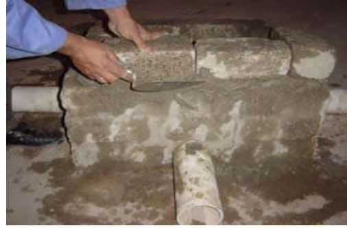
الشكل ( 5 - 30 ) أعمال بناء جدران الحوض
