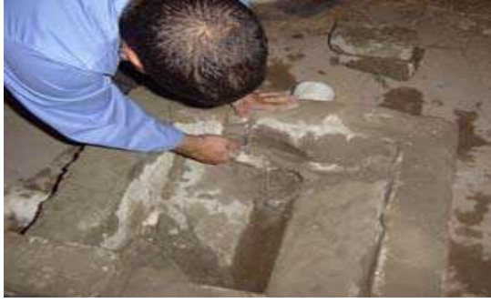
الشكل ( 5 - 31 ) أعمال بناء جدران الحوض
