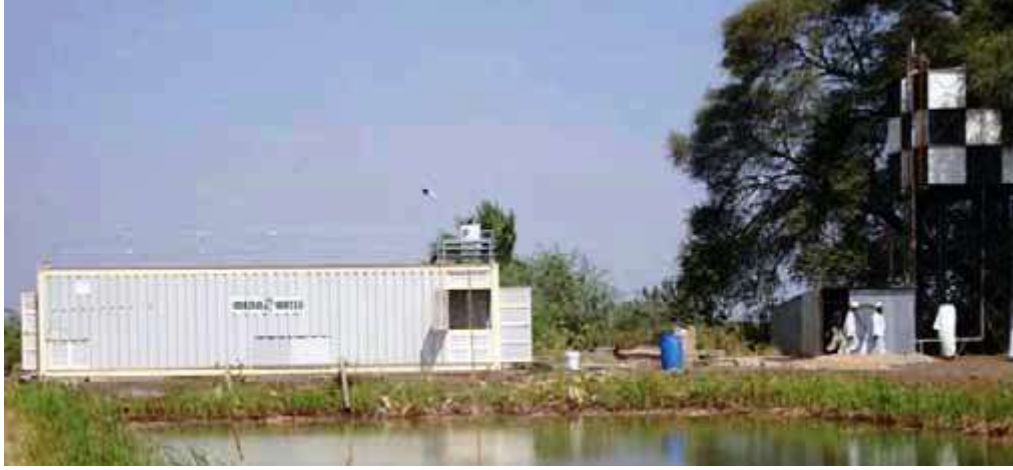
الشكل 3-8 : محطة تصفية مدمجة.
