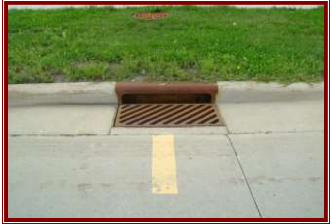
الشكل 10-21 مدخل مياه أمطار سطحي وجانبي
