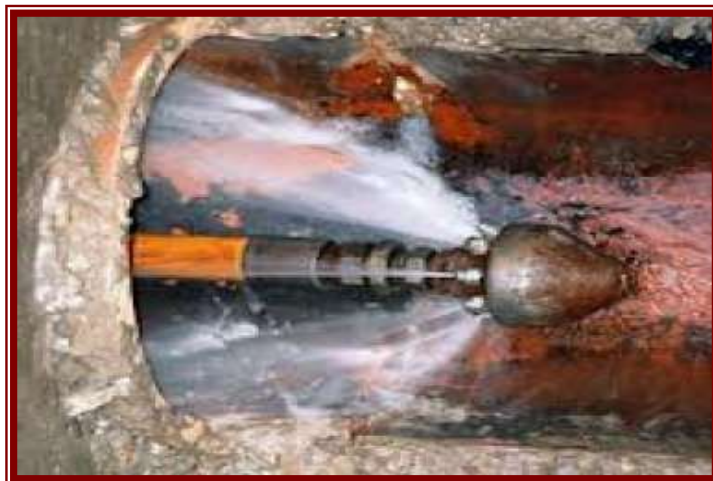
الشكل (9-10) راس خرطوم السيارة الصاروخية
