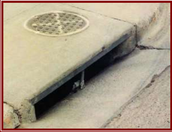
الشكل 10-21 مدخل مياه أمطار سطحي وجانبي
