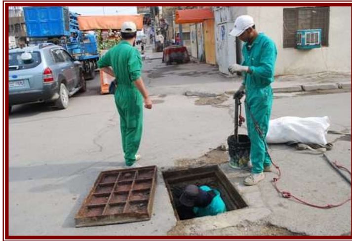
الشكل ( 10-12 ) رفع مسببات الانسدادات من قعر حوض التفتيش
