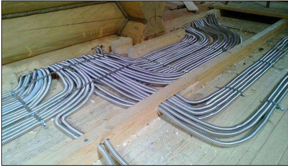
شكل (10-3) التأسيس الكهربائي باستخدام الانابيب
