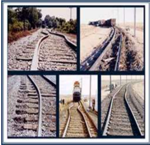
شكل 5-7 انحناء خطوط السكك الحديدية بسبب التمدد الحراري.
