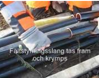
9- سحب العازل الحراري الأول الذي يتقلص بالحرارة
