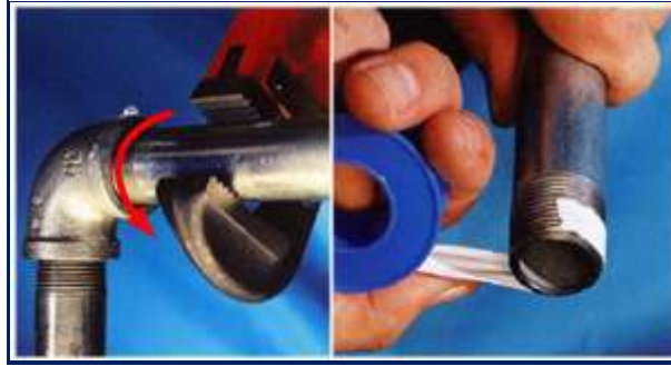
شكل 4-2 ج طريقة وضع شريط التفلون وربط الأنابيب
