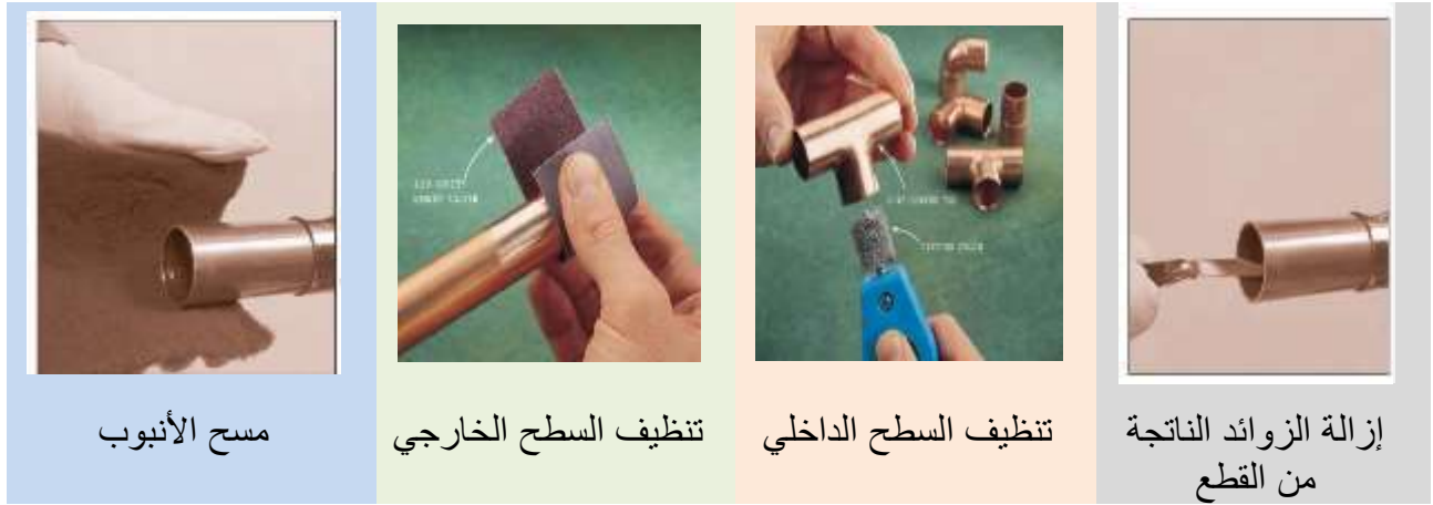
شكل 3-5 عمليات التنظيف الأربع للقطع الملحومة
