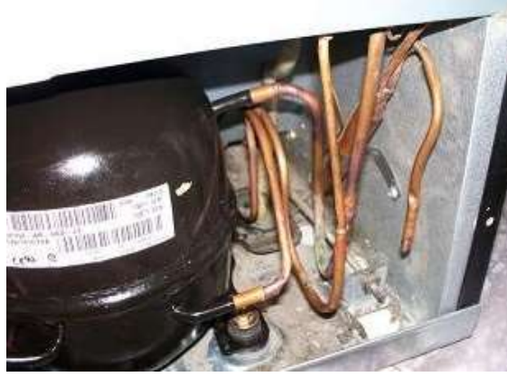
ر- الضاغط بعد النصب شكل 31-7 عملية نصب ضاغط جديد
