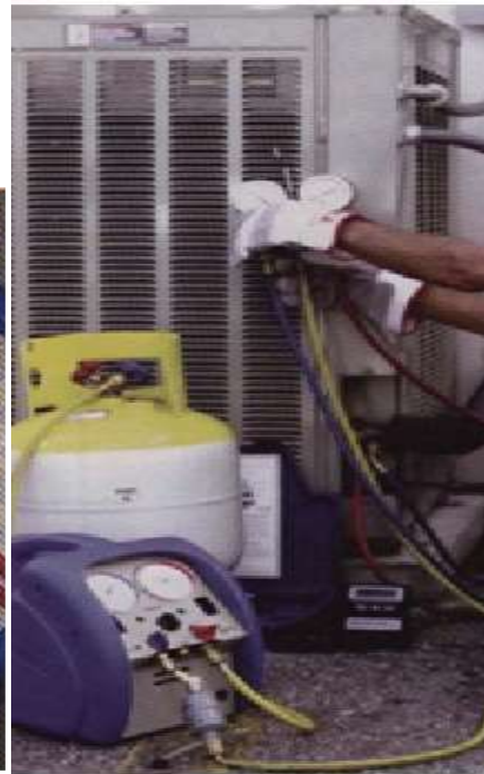
عملية إعادة تأهيل بخار مانع التثليج غمر أسطوانة إعادة تأهيل البخار في الثلج شكل 7- 27 طريقة إعادة تأهيل بخار مانع التثليج
