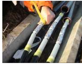
8- البدء بعزل أسطوانة الربط بعد كبسها
