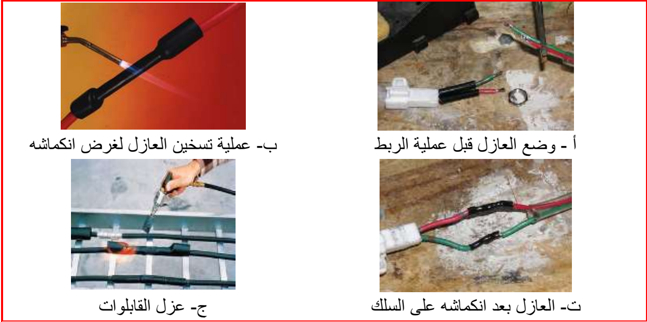
شكل 5-11 عملية عزل وصلات الربط بالعازل الذي ينكمش بالحرارة.
