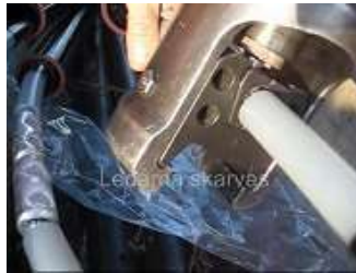
7- اضغط أسطوانة الربط بضغط هيدروليكي
