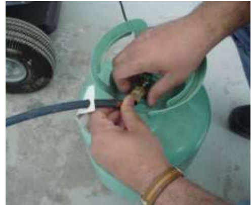
شكل رقم (408) تركيب صمام حنفية غاز التبريد
