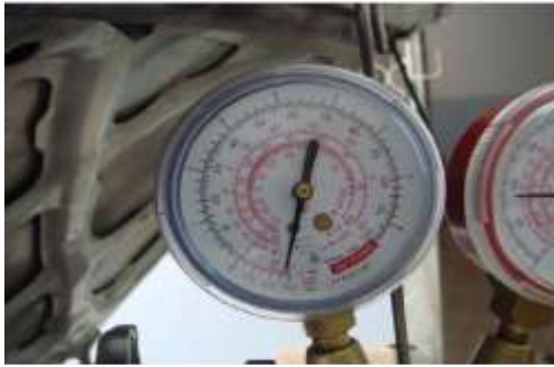
شكل رقم (405) مؤشر الضغط المنخفض عند 750 mm Hg
