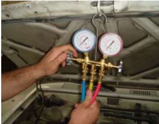
شكل رقم (409) فتح صمام الضغط المنخفض
