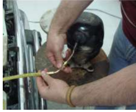
شكل رقم (402) طريقة تركيب الخرطوم الاوسط في مضخة التفريغ
