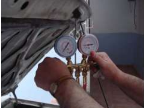
شكل رقم (403) طريقة فتح صمامي الضغط العالي والمنخفض
