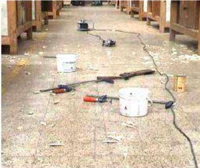
شكل رقم (1 - 14) يبين شكل الممرات عند ترك مواد العمل فيها
