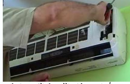
7- أرفع غطاء اللوحة الكهربائية
