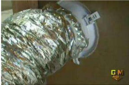
10- مجرى الهواء بعد تثبيته بناشرة الهواء
