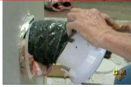
7- تركيب ناشرة الهواء في مجرى الهواء
