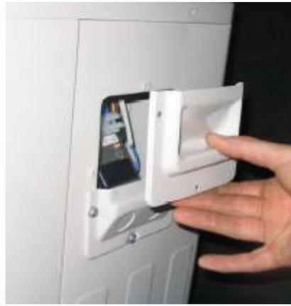
4- فتح غطاء لوحة الربط الكهربائي للوحدة الخارجية
