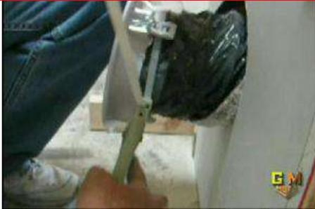
8- إحكام ربط مجرى الهواء على ناشرة الهواء
