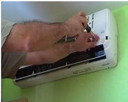
6- استعمل المفك لفتح لولب اللوحة الكهربائية
