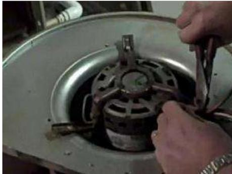
6- أقطع مثبت الأسلاك الكهربائية بجسم الناfox
