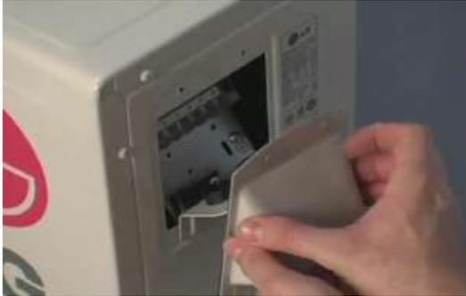
42- أرفع غطاء التوصيلات الكهربائية
