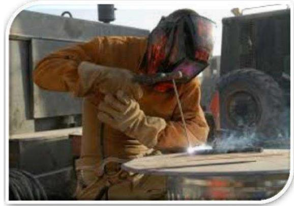
شكل 1-1 اللحام بالقوس الكهربائي المعدني اليدوي
