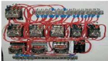
لوحة تحكم تعمل بنظام Relay
