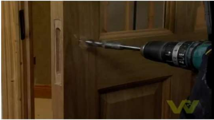
شكل (1 - 32) يبين كيفية ثقب موضع عمود
