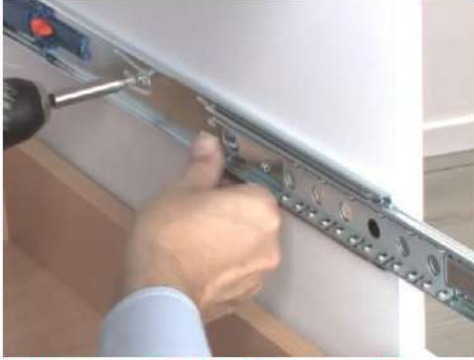
الشكل (3 - 42) يوضح كيفية تركيب جزء السكة
