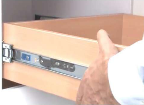
الشكل (3 - 44) يوضح تركيب الجرار الثاني داخل الكومدي
