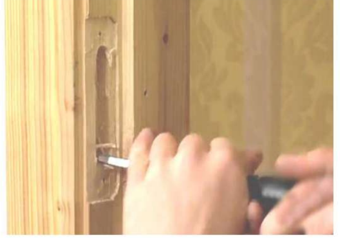
شكل (1 - 34) يبين كيفية تفرغ جزء اللسان المعدني
