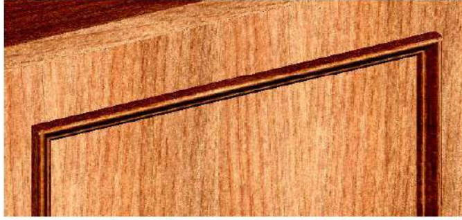
شكل (3 - 16) يبين وضع (الأبزار) أشرطة الحلية
