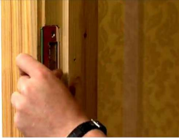
شكل (1 - 35) يبين كيفية تثبيت جزء اللسان المعدني
