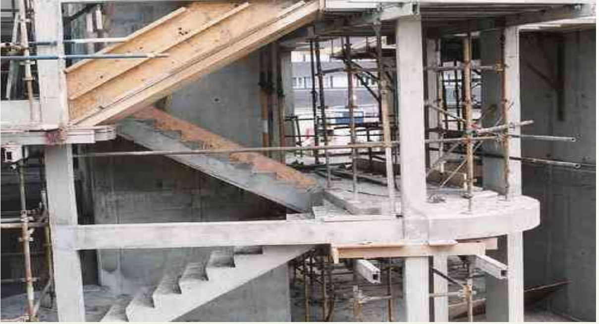
صورة لعملية إنشاء سلم خرساني مع الصحن ( للاطلاع )
