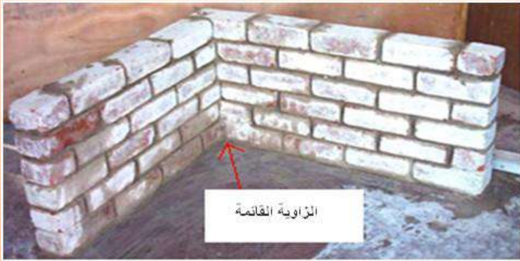
جدار طابوقي حقيقي بشكل زاوية قائمة مبني بطريقة الربط العام
