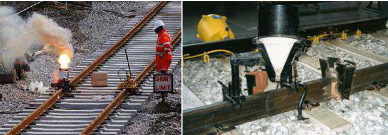
شكل 5-1 مخطط لعملية لحام الترميت
