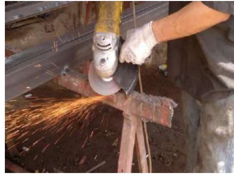
الشكل (5-26) يوضح عملية التجليخ
