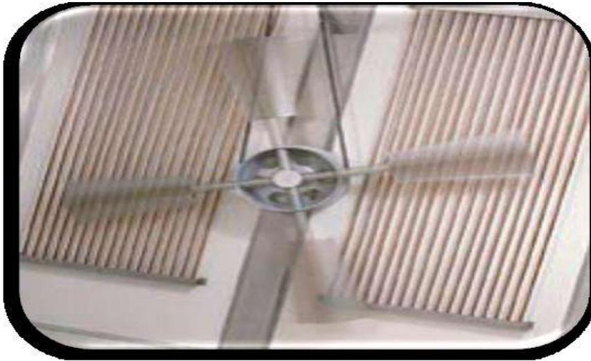
شكل رقم (2-3) يوضح مروحة تعمل على توزيع الهواء وخلفها السخانات الحرارية
