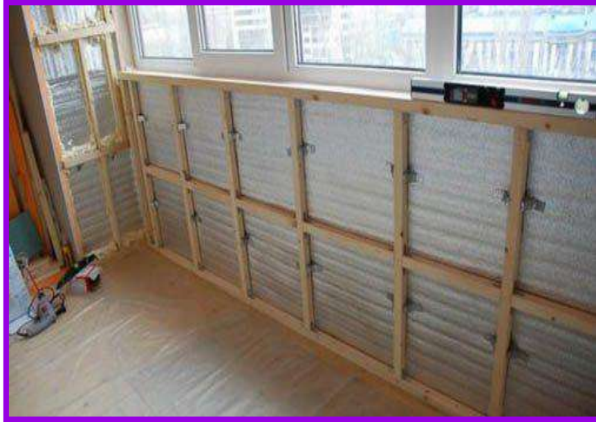
الشكل ( 4 - 3 ) طريقة تثبيت القواعد الخشبية على الجدران
