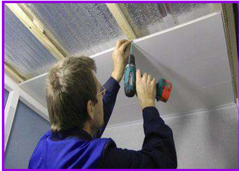
الشكل ( 4 - 4 ) يبين تثبيت اللوح الى القواعد الخشبية
