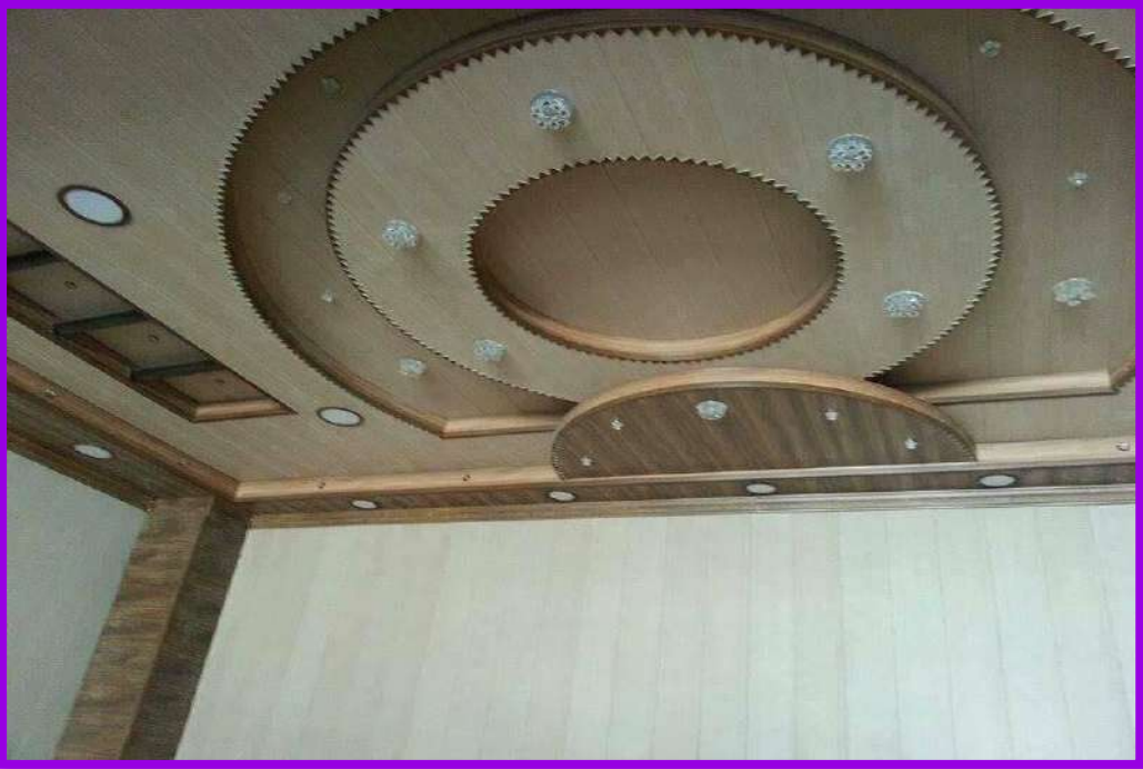
الشكل (4 - 6) تغليف فضاء داخلي جداري وسقف بالالواح البلاستيك
