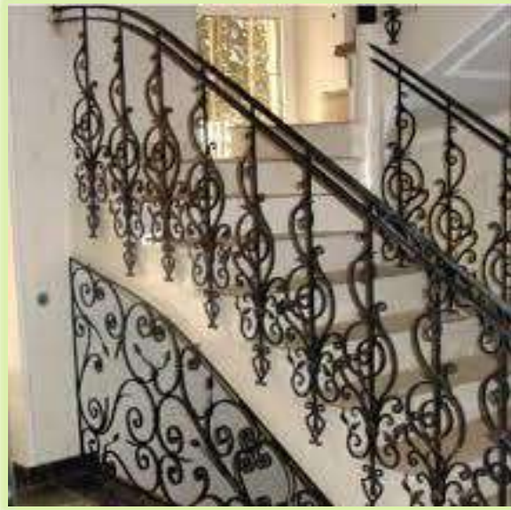
الشكل (1-6) يوضح المحجرات الحديدية
