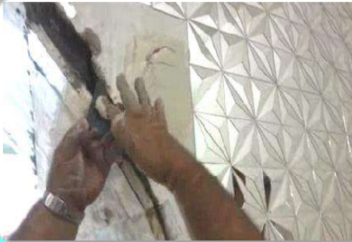
الشكل (6-49) تثبيت قطع المرآه المثلثة
