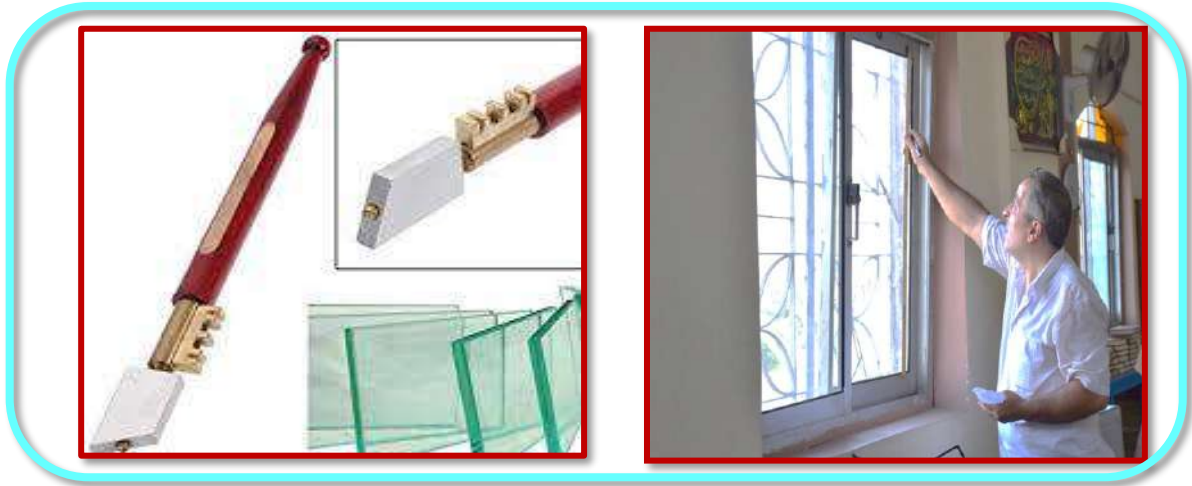
الشكل (6-54) خطوات تثبيت الزجاج
