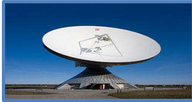
الشكل 5-8 هوائي القطع المكافئ
