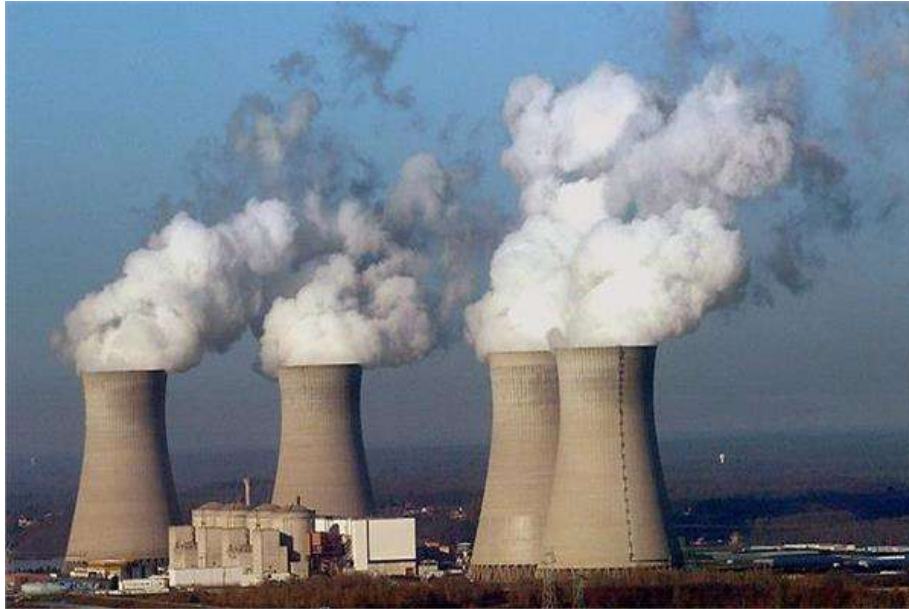
الشكل (4-5) مفاعل نووي وتظهر كمية كبيرة من البخار الخارج من ابراج تبريد المفاعل نتيجة لتبخر الماء في كمية الحرارة العالية التي يولدها الوقود النووي
