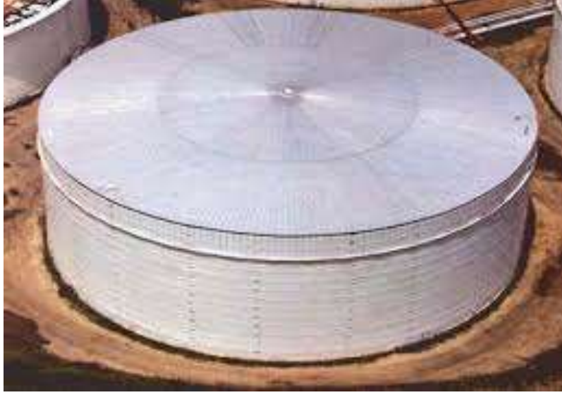
الشكل (5-21) خزان ذو سقف ثابت
