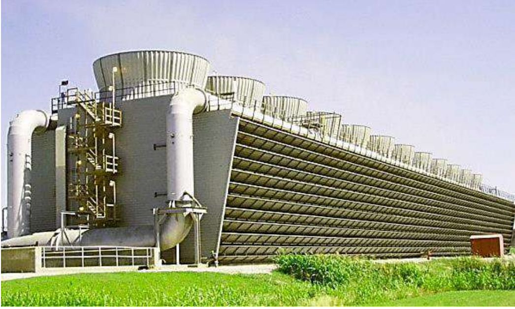
شكل (1-6) أبراج تبريد المياه في المصافي النفطية
