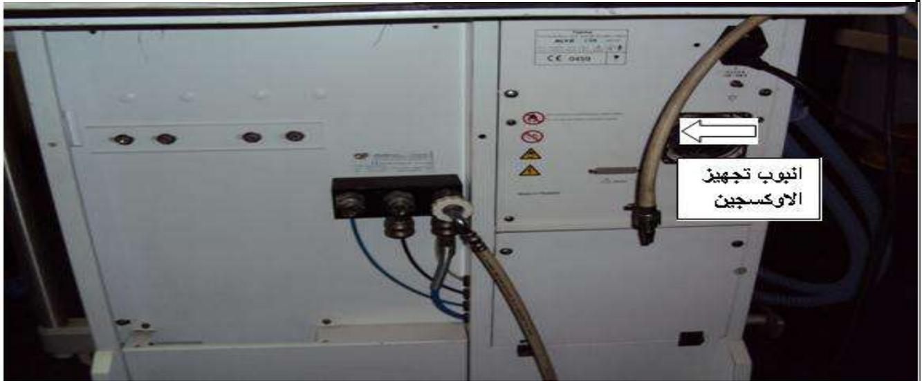
أ - افتح الأوكسجين المجهز سواء من (الاسطوانة) أو أنابيب التجهيز في المستشفى لرؤية مقياس الأوكسجين ثم افتح جهاز الهواء.
