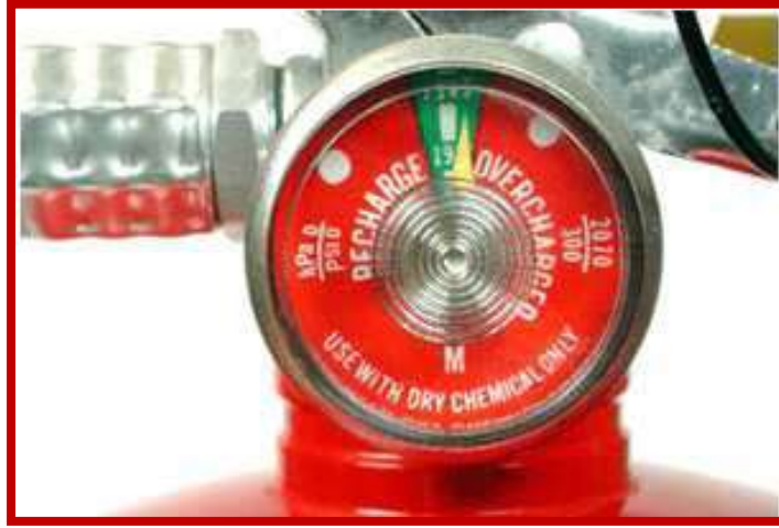
الشكل رقم (1-24) يبين مقياس الضغط في مطافئ الحريق
