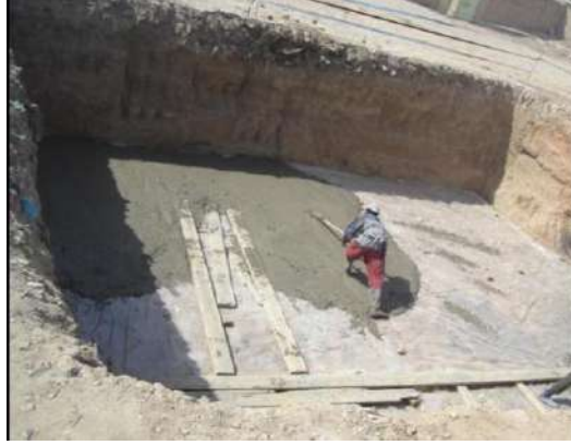
الشكل (2-11) عمل حفرة بعمق 2.5m أبعادها ضعف أبعاد قاعدة البرج
