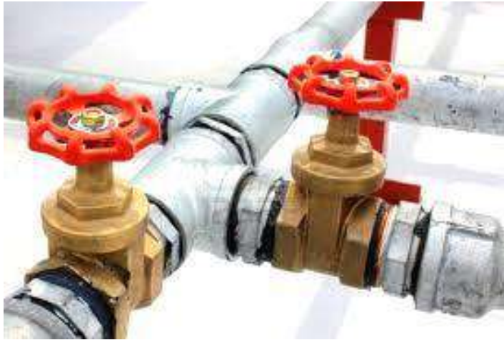
الشكل (1-15) طريقة ربط انابيب الماء
