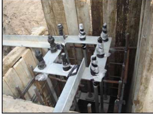
الشكل (2-17) تثبيت الهيكل الحديدي لقاعدة البرج في الهيكل الحديدي للحفرة
