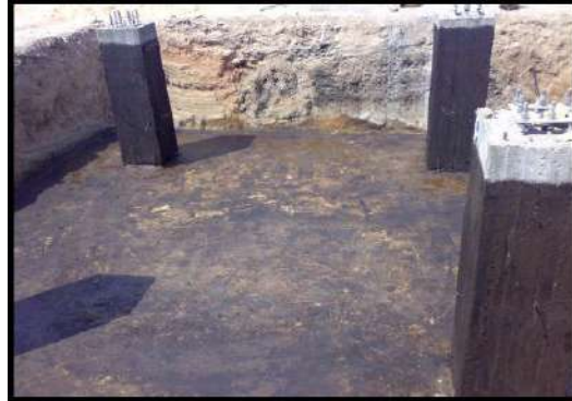
الشكل (2-19) سكب الأسفلت المانع للرطوبة في حفرة البرج وعلى مساند أرجل البرج
