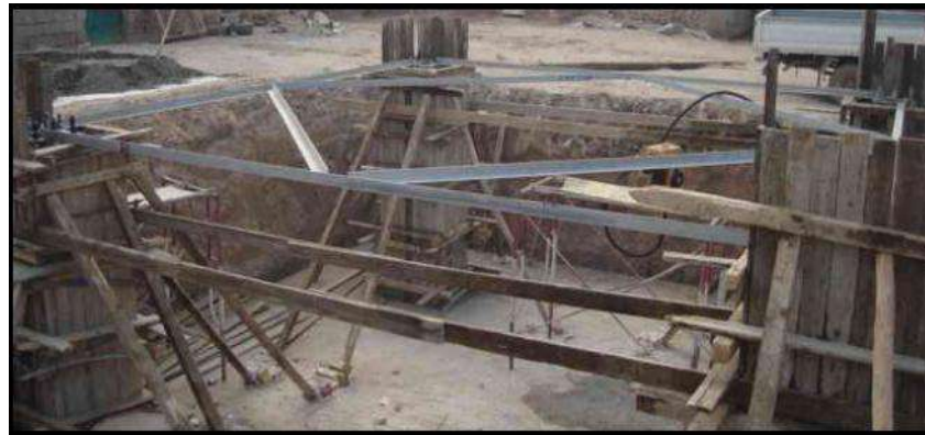
الشكل (2-16) تركيب الهيكل الحديدي لقاعدة البرج بين مساند الأرجل
