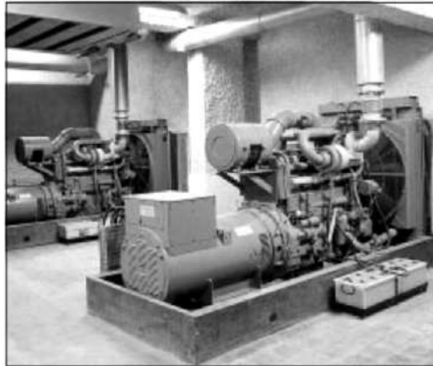
الشكل (5-36) ربط مجموعة مولدات صغيرة بالشبكة الكهربائية
