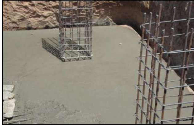
الشكل (2-14) صب قاع حفرة البرج بالخرسانة الكونكريتية
