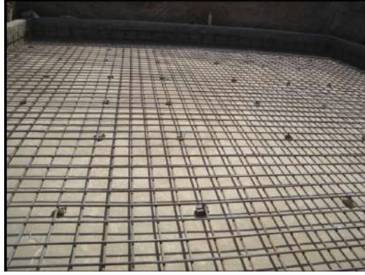
الشكل (2-12) شبكة حديد التسليح في قاع حفرة برج الضغط العالي
