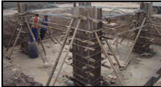
الشكل (2-15) عمل قالب خشبي لمساند أرجل برج الضغط العالي
