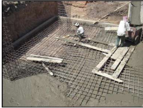
الشكل (2-13) عمل هيكل من الحديد لتثبيت أرجل البرج فوقها
