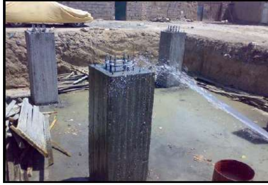
الشكل (2-18) صب الخرسانة الكونكريتية لمساند أرجل البرج
