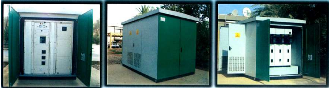
الشكل (4-7) b المحطة الصندوقية KIOSK
