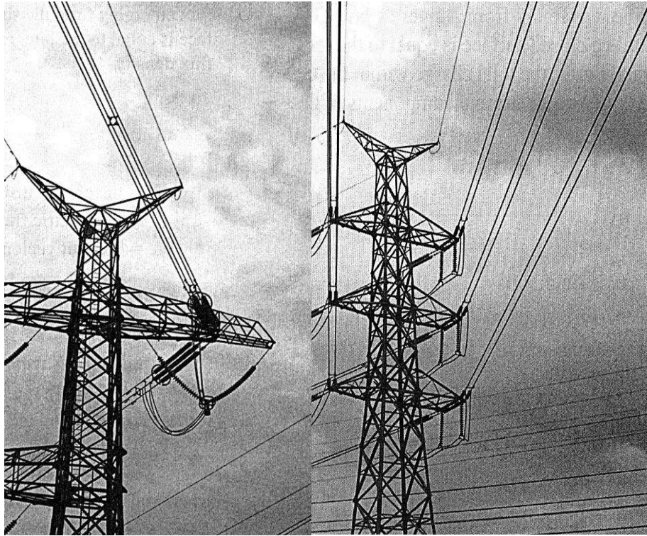
الشكل (2-37) النواقل معلقة مزدوجة أو رباعية على عوازل النواقل الأبراج
