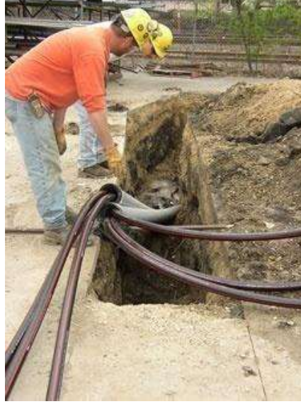
الشكل (2-69) تمديد الكيبلات المفردة داخل انابيب بلاستيكية
