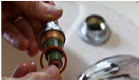
الشكل (3-26) طريقة تركيب مانعة التسرب العليا للحنفية
