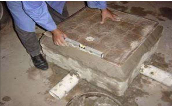
الشكل ( 5 - 35 ) أعمال تثبيت إطار الغطاء
