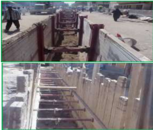
الشكل (2-6) استخدام الخنادق بسواتر خشبية
