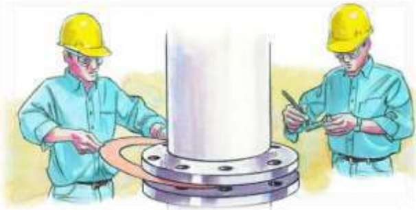
الشكل (2 - 55) يوضح عملية ابدال حشوة (كازكيت) متضررة
