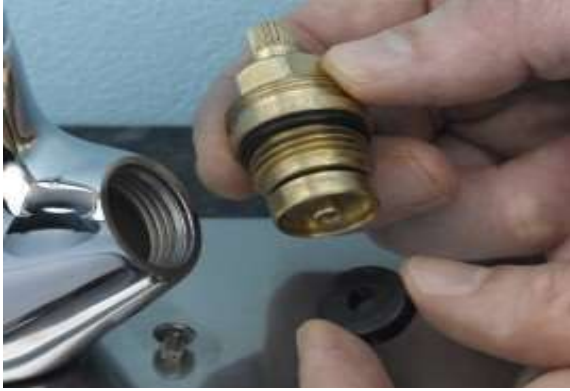
الشكل ( 39-3 ) طريقة تركيب مانعة التسرب لقلب حنفية
