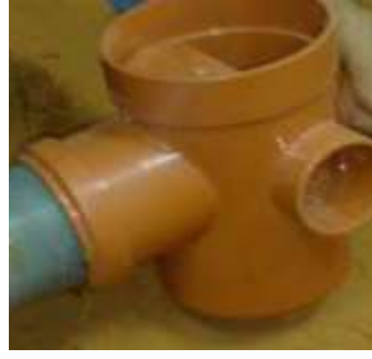
الشكل ( 5-5 ) مرحلة التوصيل بالموزع الاسطواني
