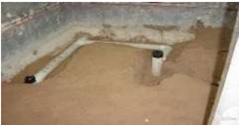
الشكل ( 5 - 11 ) ربط الموزع والسيفون بالمشترك الخارجي
