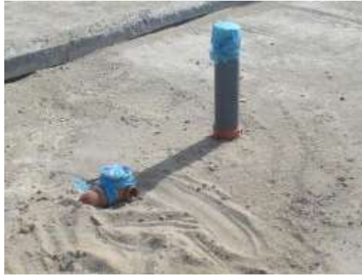
الشكل ( 5 - 17 ) شبكة الصرف بعد صب الخرسانة
