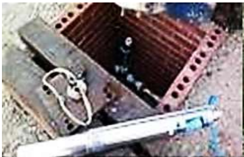
الشكل ( 3-50 ) يوضح وضع الصمّام تحت سطح الارض
