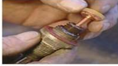
الشكل ( 3-29 ) صامولة لتثبيت مانعة التسرب في مكانها
