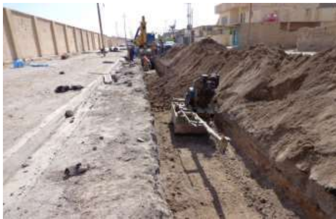
الشكل ( 4-7 ) دك خندق الحفر بعد مد الأنابيب
