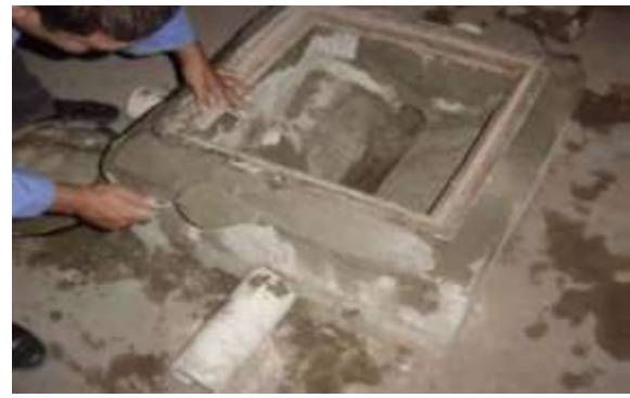
الشكل ( 5 - 34 ) أعمال تثبيت إطار الغطاء
