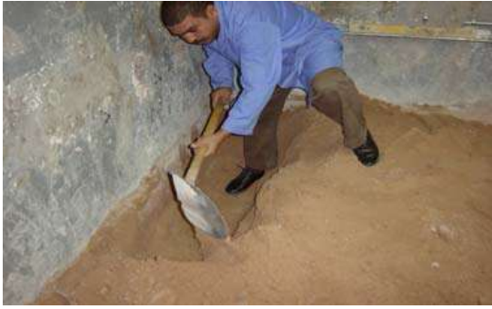
الشكل ( 9 - 5 ) أعمال الحفر
