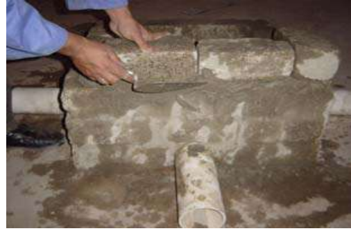
الشكل ( 5 - 30 ) أعمال بناء جدران الحوض
