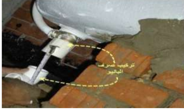
الشكل ( 3 - 10 ) انبوب الفائض واسخدام السيوفون
