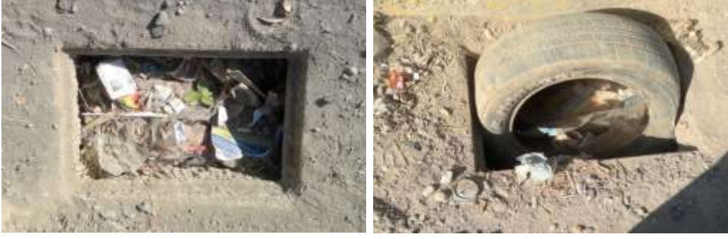
الشكل ( 1-7 ) بالوعة أمطار فيها إنسداد
