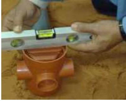
الشكل ( 5-5 ) مرحلة التوصيل بالموزع الاسطواني
