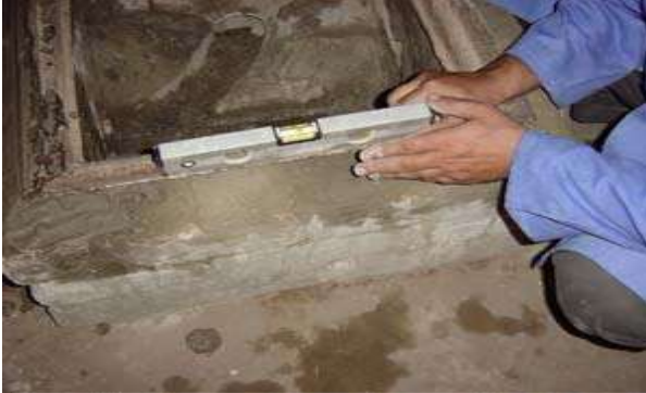
الشكل ( 5 - 33 ) أعمال تثبيت إطار الغطاء
