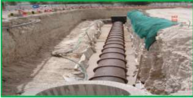
الشكل (3-6) إستقامة الخطوط بعد انشائها
