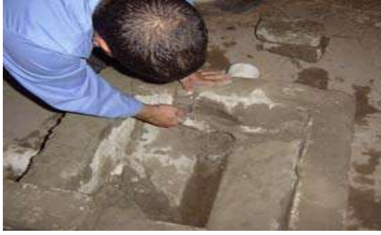
الشكل ( 5 - 31 ) أعمال بناء جدران الحوض
