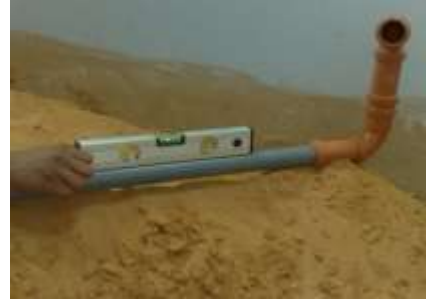
الشكل ( 6-5 ) تمديد خطوط الصرف للموزع الاسطواني
