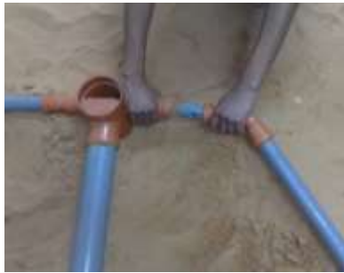
الشكل ( 6-5 ) تمديد خطوط الصرف للموزع الاسطواني
