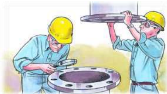
الشكل ( 2 - 53 ) يوضح فحص الفلنجات قبل الربط
