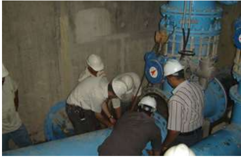
الشكل (2 - 55) يوضح عملية ابدال حشوة (كازكيت) متضررة
