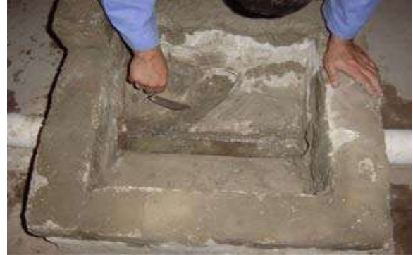
الشكل ( 5 - 32 ) أعمال بناء جدران الحوض
