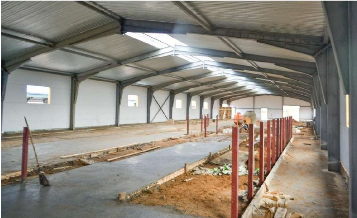
شكل (3-6) صب ارضيات الحظائر وتثبيت أعمدة الحديد
