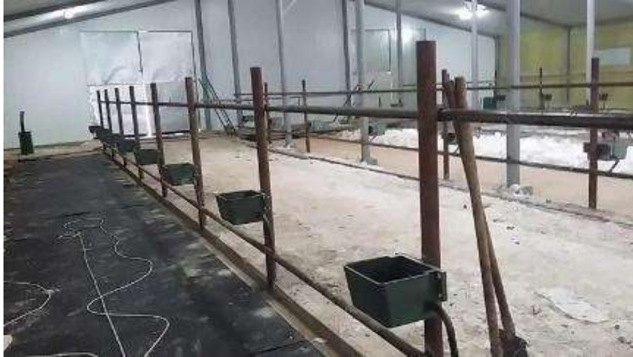
شكل (19-6) تثبيت الأعمدة الحديدية لتحديد أماكن البقر ومد أنابيب المياه
