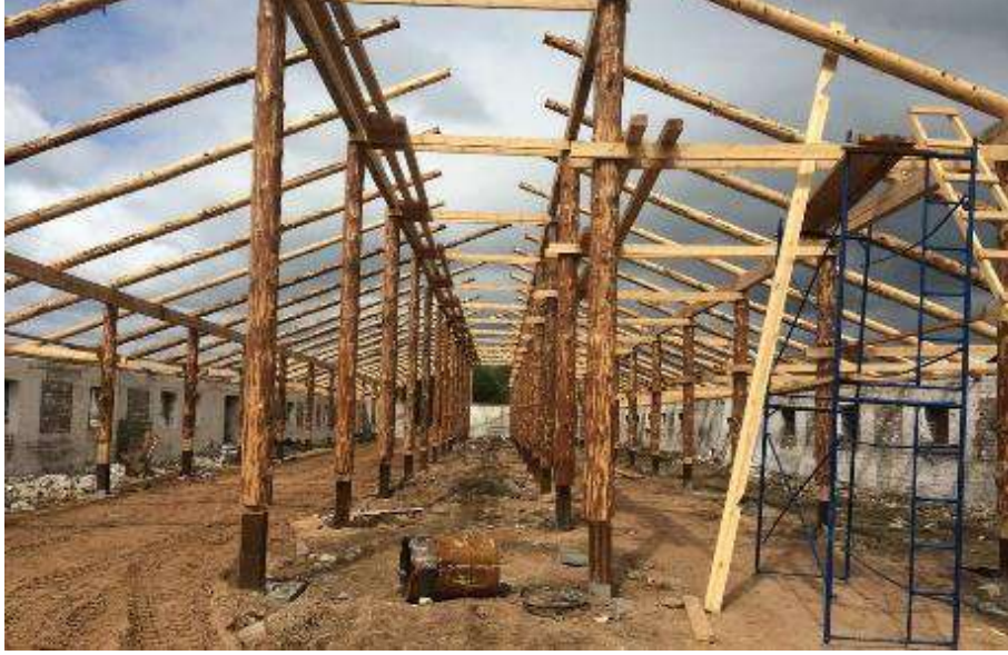
شكل (6-18) نصب الأعمدة في الأماكن المحددة لها
