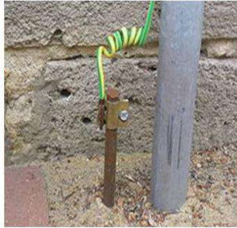
شكل (4- 5) يوضح التود الأرضي
