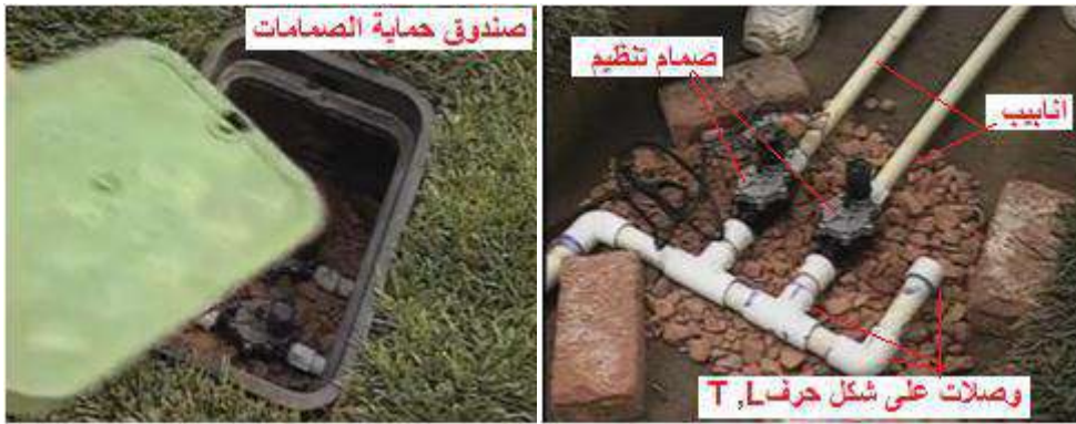
شكل 6-18 ربط الأنابيب بالمفاتيح
