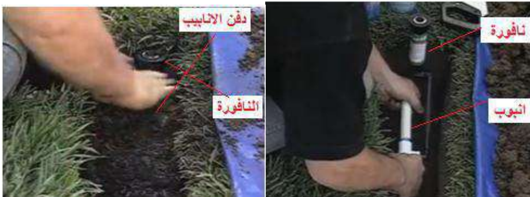
شكل 6-19 وضع النافورة مكانها ودفنها مع الأنابيب بالتراب
