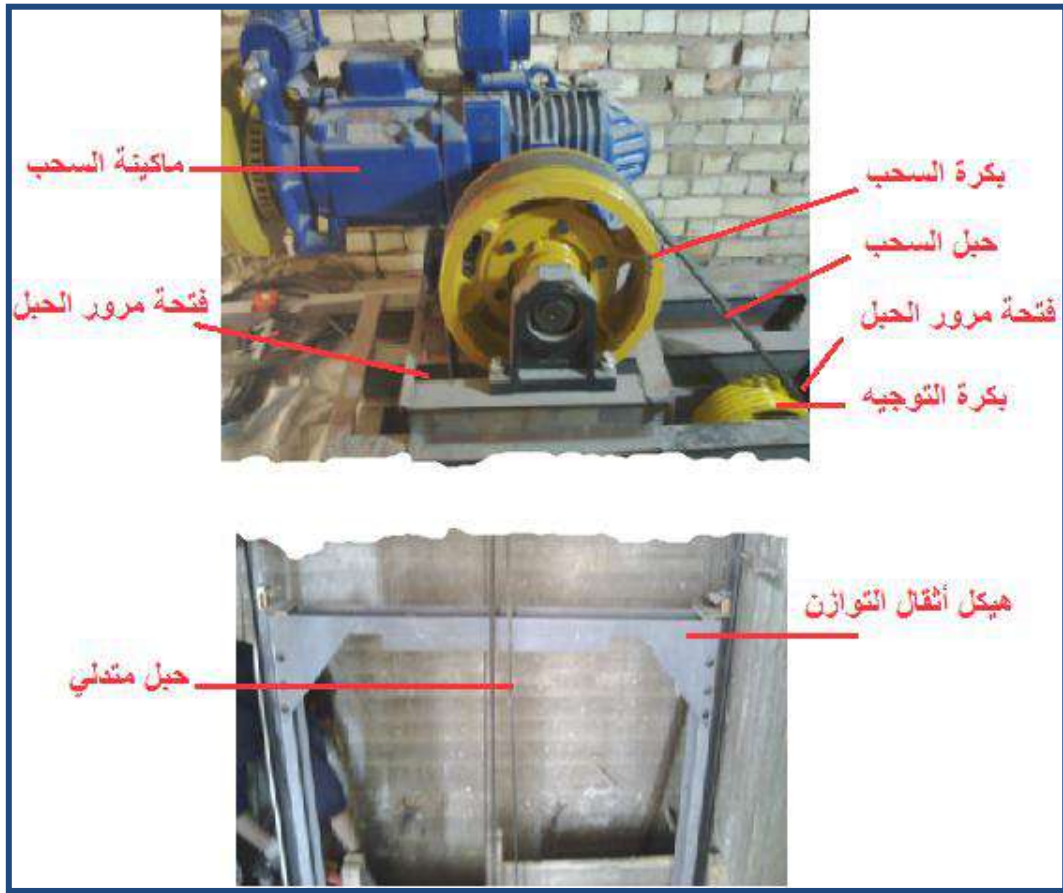
شكل (1 - 13) إمرار الحبل في مسار حول بكرة السحب باتجاه الثقل المعادل
