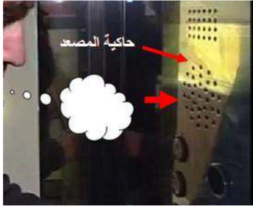
شكل (2-4) مناداة الأشخاص المحجوزين عن طريق الحاكية من قبل رجل الصيانة
