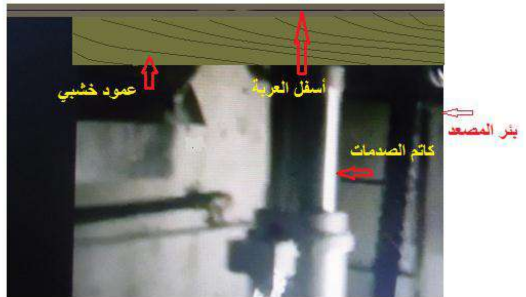
شكل (1 - 37) تثبيت عمود من الخشب طوله (1.5m-2m) بين كاتم الصدمات وأسفل العربة
