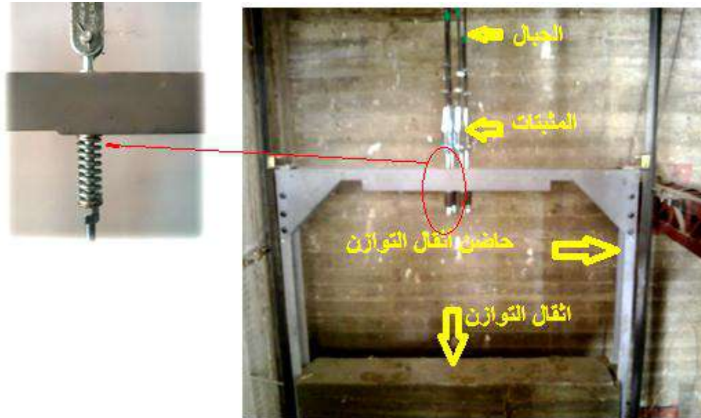
الشكل (1 - 17) إدخال عمود المثبت خلال فتحة تعليق الثقل المعادل وتثبيتها
