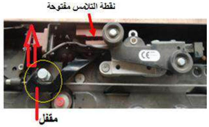
شكل (1- 31) فحص أنطباق خطاف قفل الباب ونقطتي التلامس الكهربائي
