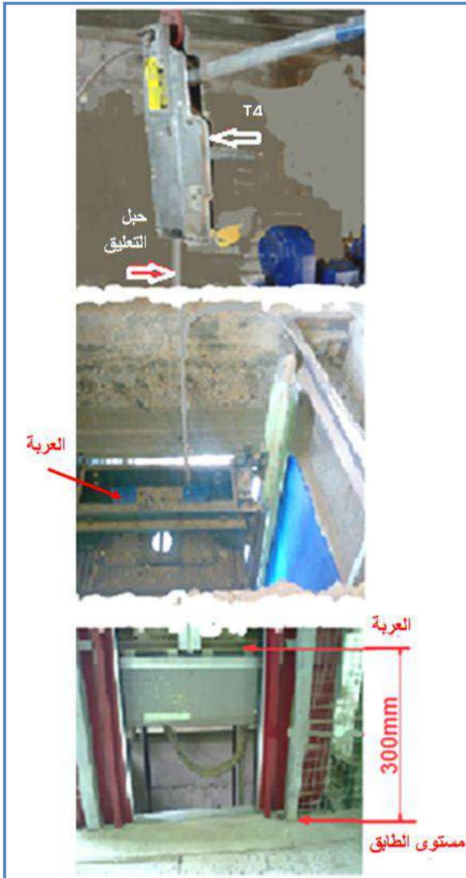
شكل (1 - 10) تعليق العربة بواسطة أداة التعليق (T4)
