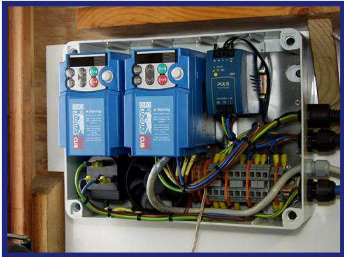
الشكل (5-10) يمثل أجهزة (Ac-inverter) عدد (2) في لوحة سيطرة لتشغيل محركات 3ph
