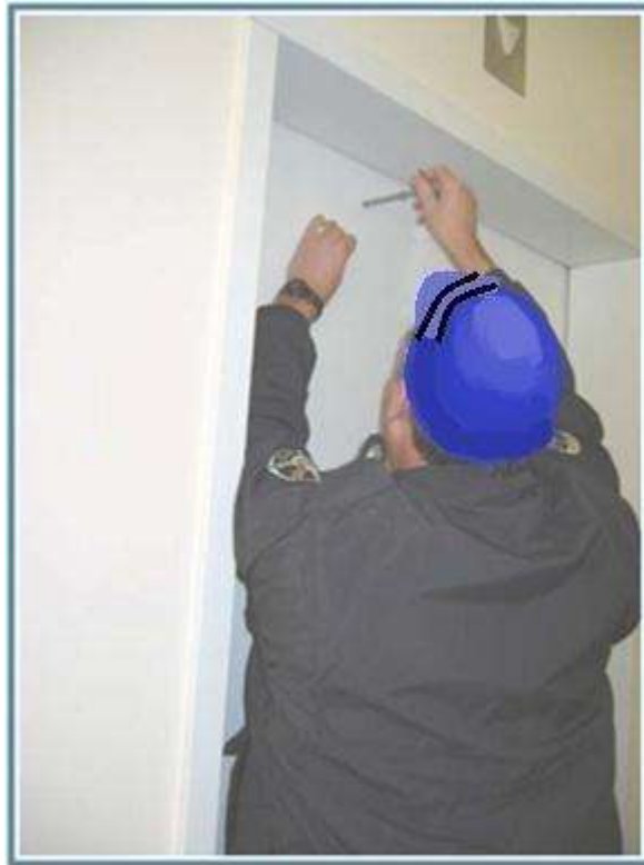
شكل (5-4) فتح الباب الخارجي بواسطة مفتاح الطوارئ الميكانيكي
