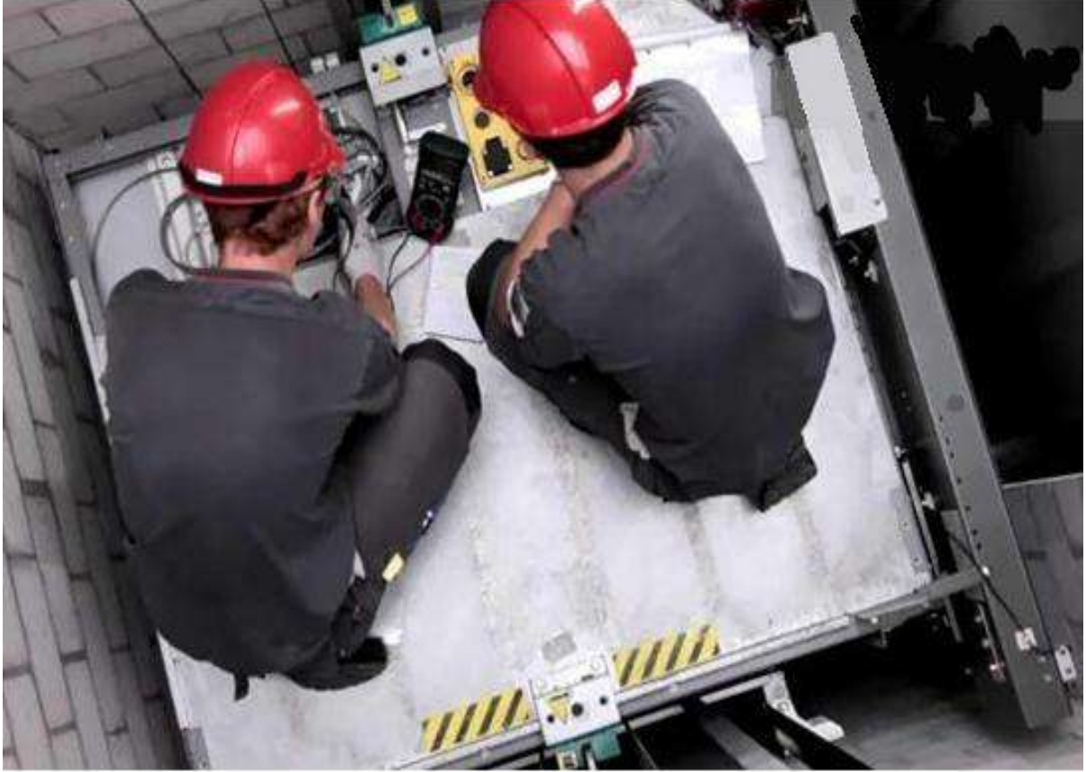
شكل (1-4) عمال الصيانة وهم جالسون فوق عربة المصعد لاجراء عملية الصيانة
