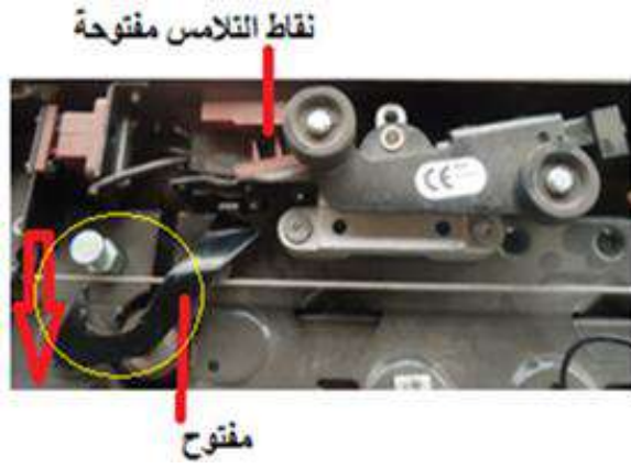
شكل (1- 31) فحص أنطباق خطاف قفل الباب ونقطتي التلامس الكهربائي
