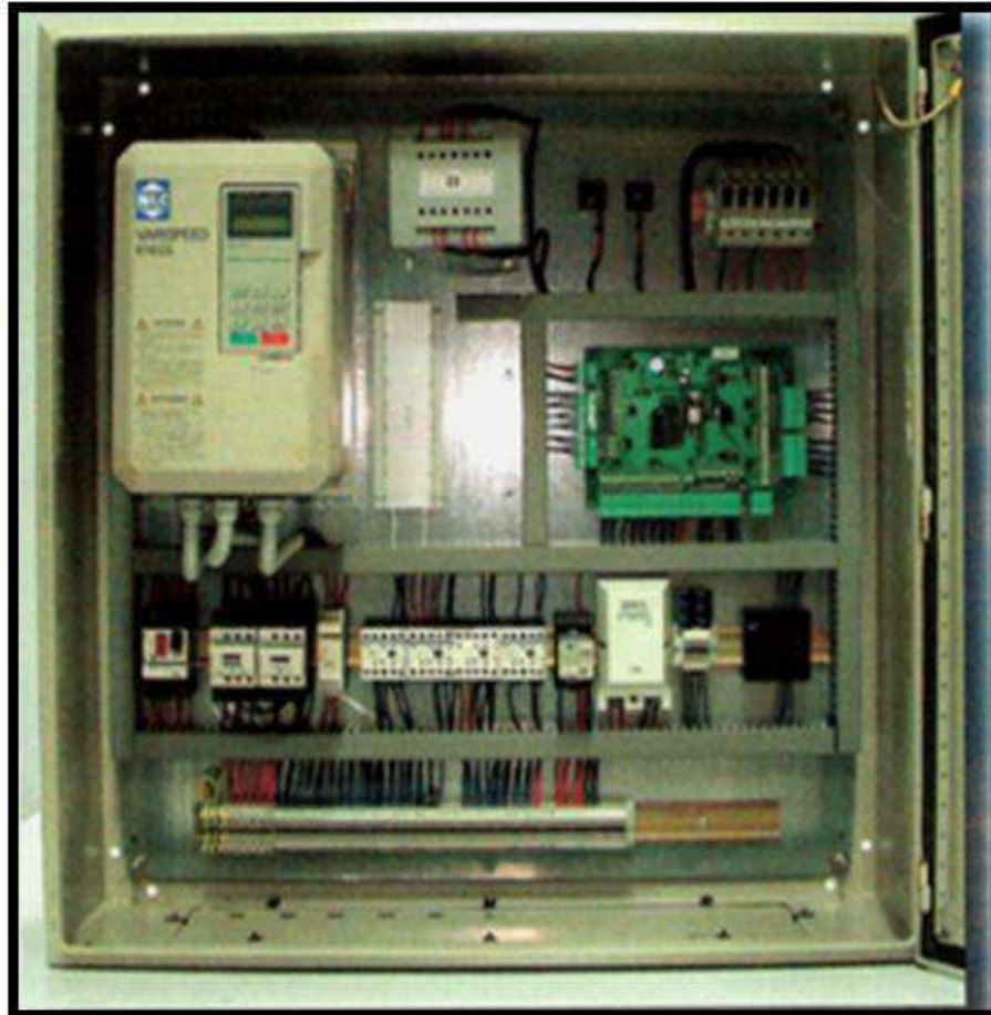
الشكل (2-3) محتويات لوحة سيطرة لمصعد كهربائي
