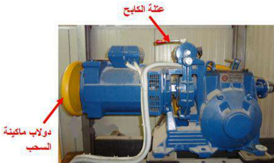
شكل (1 - 22) فتح الكابح المغناطيسي ببطء للسماح بحركة العربة
