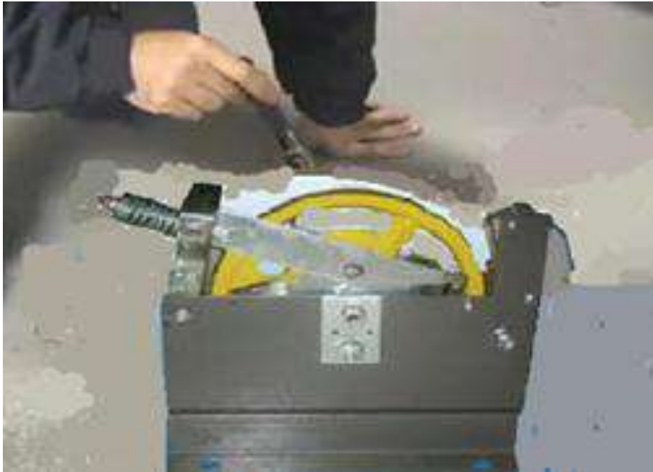
شكل (1 - 49) فحص أجزاء محكم السرعة بالبصر
