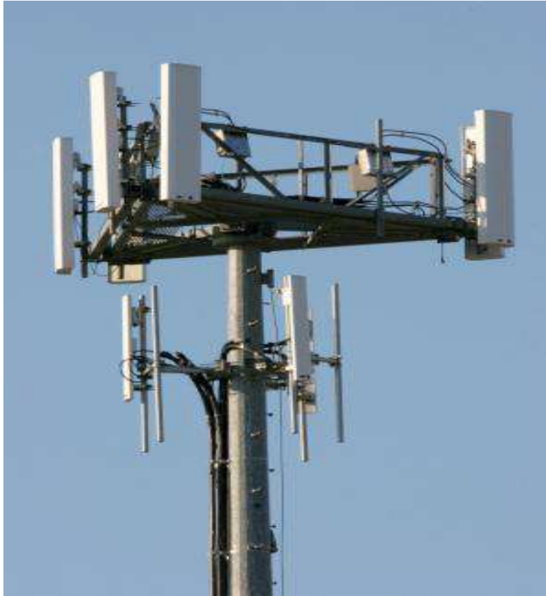
الشكل 13-1 هوائي شبكة متعدد الاتجاهات
