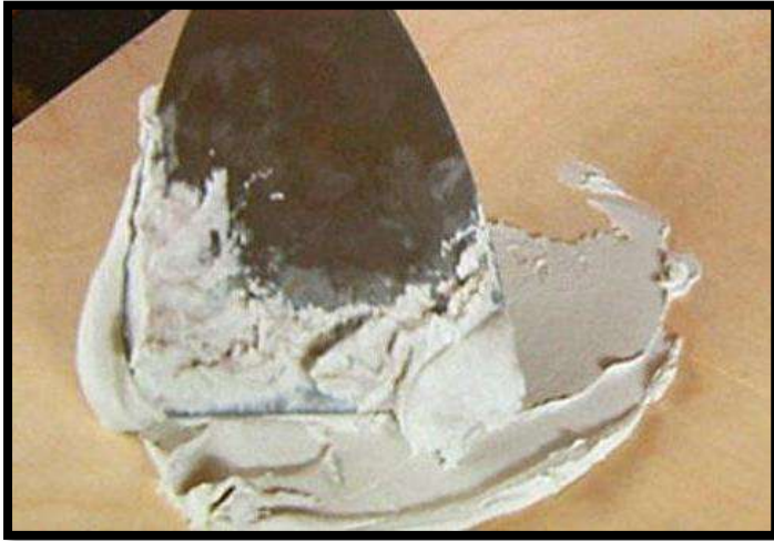
الشكل (1-65) يوضح علاج خدوش السطح الخشبي
