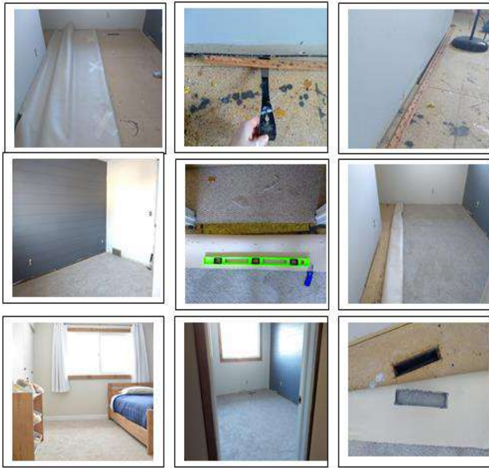
الشكل (14-2) تركيب موكيت الأرضيات
