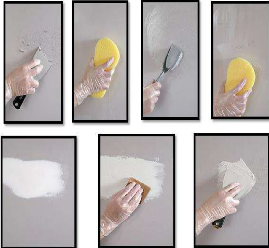
الشكل (2-10) معالجة وتنظيف الجدار قبل الطلاء
