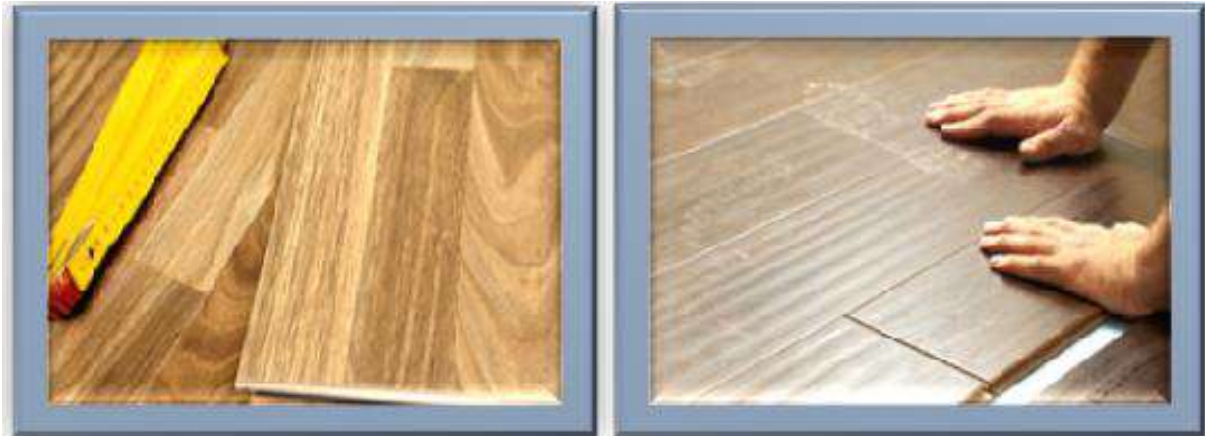
الشكل الشكل (2-3) تركيب الواح
