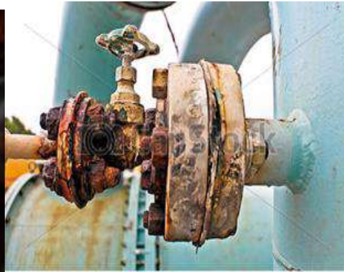
شكل (1 - 51) تعرض الصمامات إلى التآكل والنضوح والتلف
