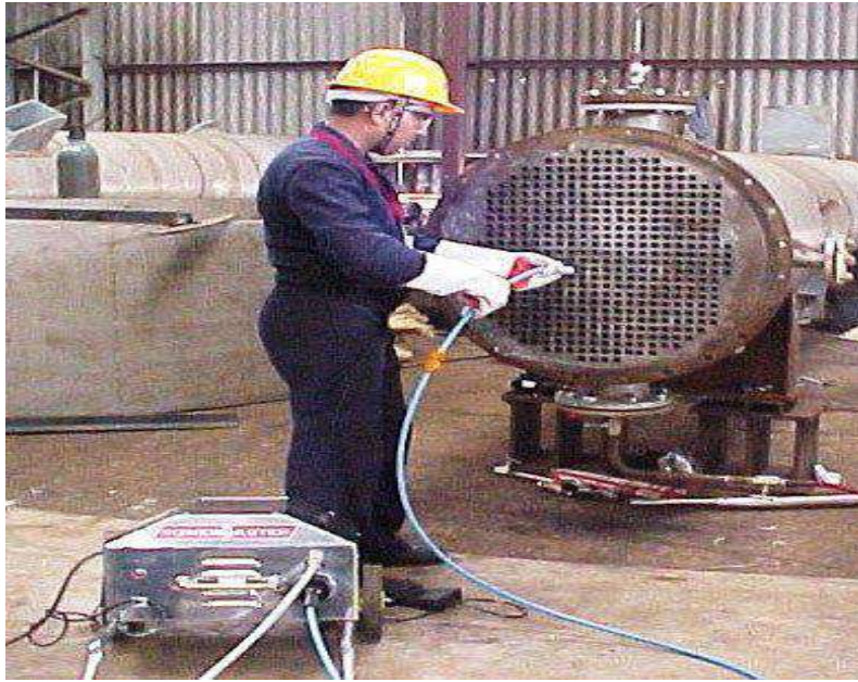
شكل (1 - 61) تنظيف انابيب مبادل حراري
