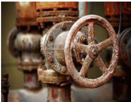
شكل (1 - 51) تعرض الصمامات إلى التآكل والنضوح والتلف
