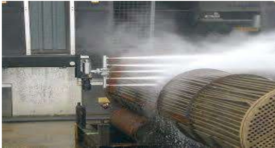
شكل (1 - 62) تنظيف خارجي لمبادل حراري
