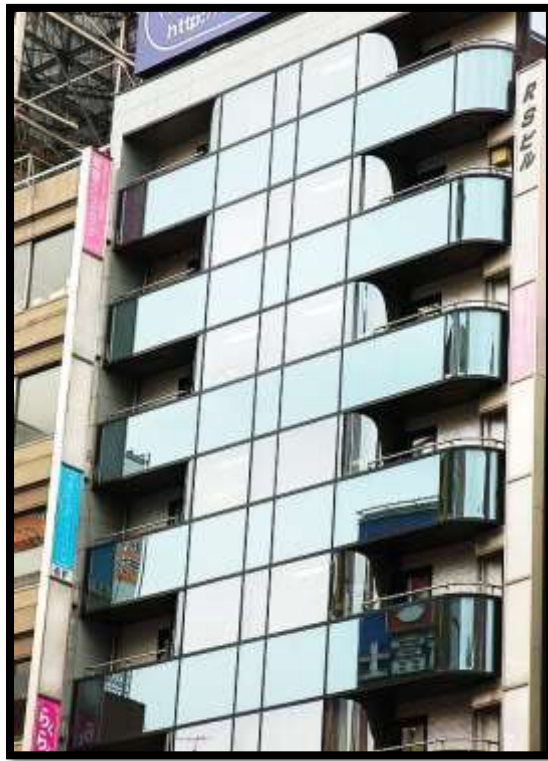
شكل (8-3) يوضح المباني الزجاجية
