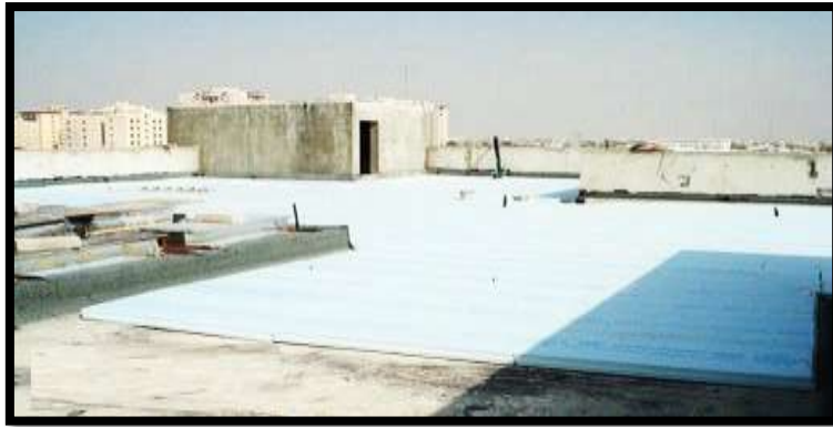
شكل (3-9) يوضح اللباد كعازل حراري للمباني
