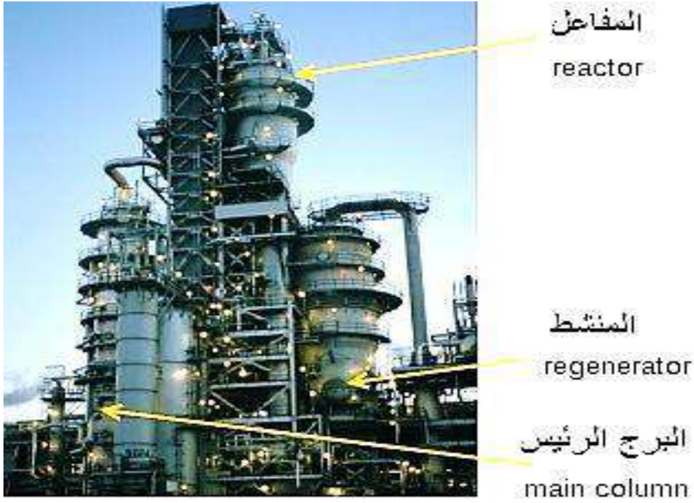
شكل ( 15-1 ) صورة لوحدة التكسير في مصافي النفط موضحة عليها الاجزاء الرئيسية للوحدة .
