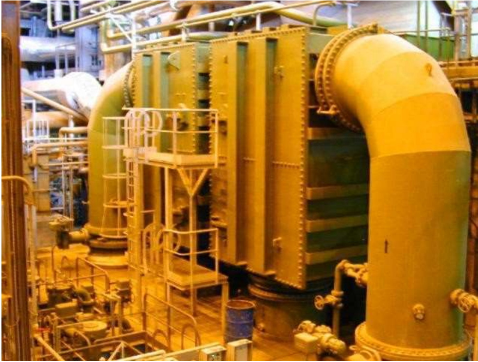
الشكل (22) يوضح صورة لمكثف في محطة حرارية ( للاطلاع فقط )
