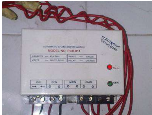
شكل ( 11 - 4 ) يوضح مفتاح تحويل أوتوماتيك
