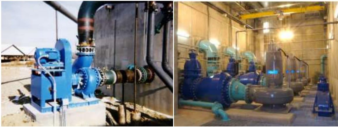
الشكل 4-14 : مضخات في محطات تصفية المياه.
