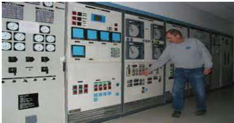
الشكل 5-1 لوحة التحكم والسيطرة مثبت عليها اجهزة القياس.
