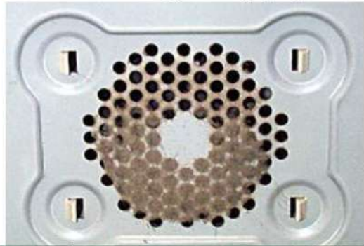
الشكل (5-24) تنظيف فتحات التهوية لمجهز القدرة
