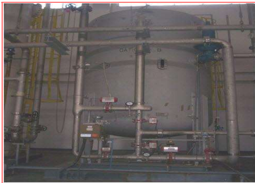
شكل 10-6 صورة لمبادل كاتيني في محطة حرارية
