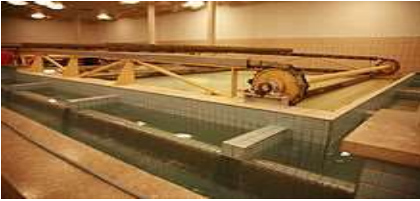
شكل ( 4 - 6 ) احواض الترسيب المستخدمة في معالجة المياه الملوثة
