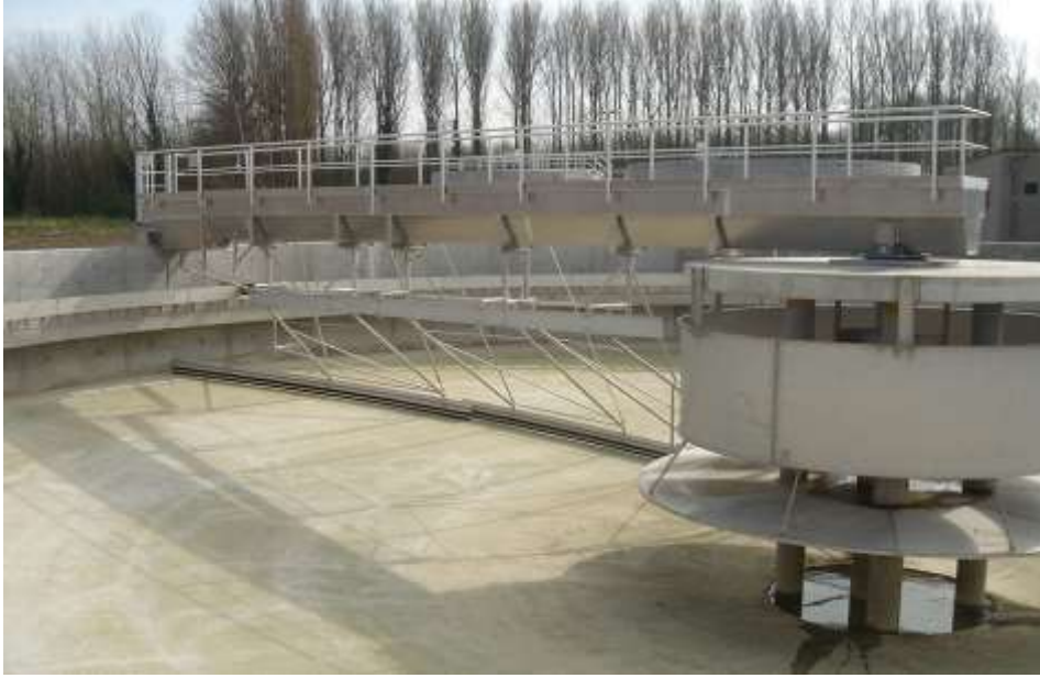
شكل ( 6 - 5 ) حوض الترسيب المستخدم في عملية التخثير الكيميائي
