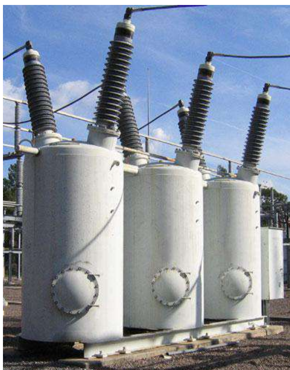
الشكل (11-6) يوضح القاطع الآلي الزيتي
