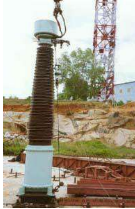
الشكل (6- 9) يوضح محول تيار
