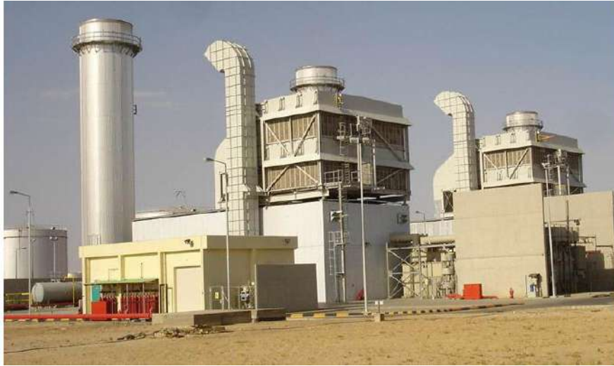
الشكل (1-2) يوضح محطة توليد كهرباء غازية
