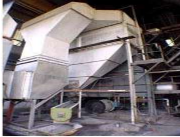
الشكل (19 -1) يوضح وحدة تجميع الاتربة والرماد
