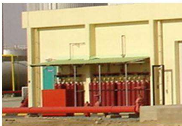
الشكل (2-8) يوضح أسطوانات غاز الأطفاء (CO 2 ) في المحطة الغازية
