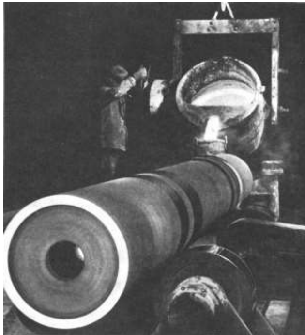
الشكل 5-9 سباكة بالطرد المركزي لأنبوب طويل وطريقة صب منصهر المعدن
