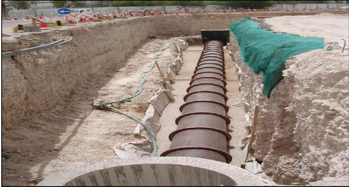
الشكل (3 – 1) مد شبكات الصرف الصحي
